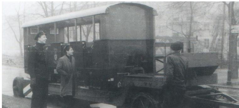
Zwei Berliner S-Bahn-Ausbesserungswerke bauten 1956 auf sächsischen Untergestellen acht geschlossene Wagen in zwei Bausereien für die Berliner Pioniereisenbahn. Im Bild die ein Wagen der ersten Bauserie aus dem Raw Warschauer Straße. Alle acht gelangten 1969/1973 nach Cottbus.
